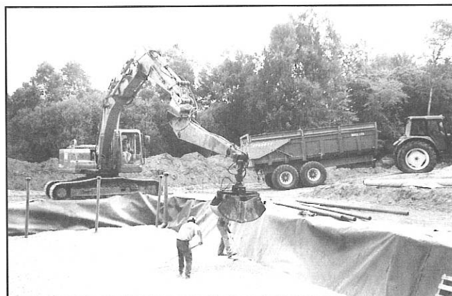
Début des travaux à la station d'épuration
