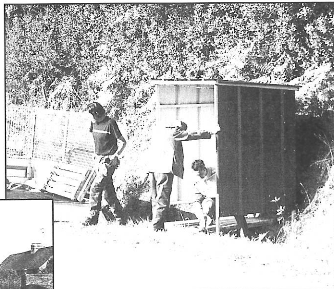
Pose d'un abribus à Kerandiot
