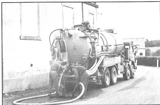
Contrôle du réseau d'assainissement dans le bourg
