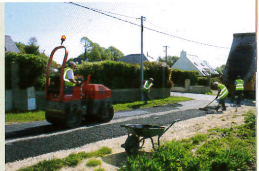
Travaux Rue de Guervihan
