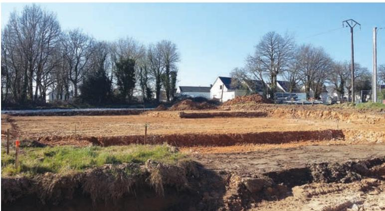
*En février les travaux d'enfouissement des réseaux, de la ligne à 20 000 volts ont été effectués par la société RSB suivis en mars des travaux de la nouvelle voirie et le terrassement de la salle par Eurovia, la mise en place des réseaux d'eaux pluviales par TPC Ouest ; ces derniers sont financés par Lorient Agglomération.*
