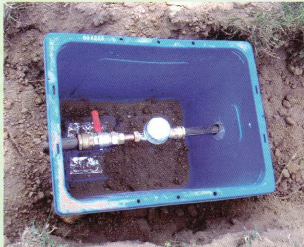
Pose d'un compteur pour raccordement au réseau
