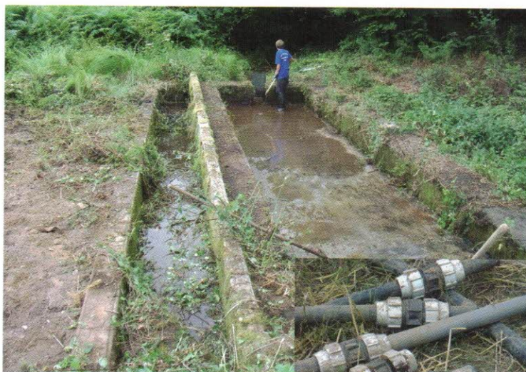
Chantier à Cosqueric
