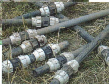
Travaux rénovation réseau
